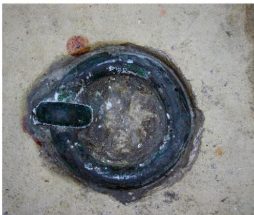
Fig. 17: *Elemento metálico oxidado* com o chamado “verdete”. Capela de São Bartolomeu, Aveiro. Foto: NR.
