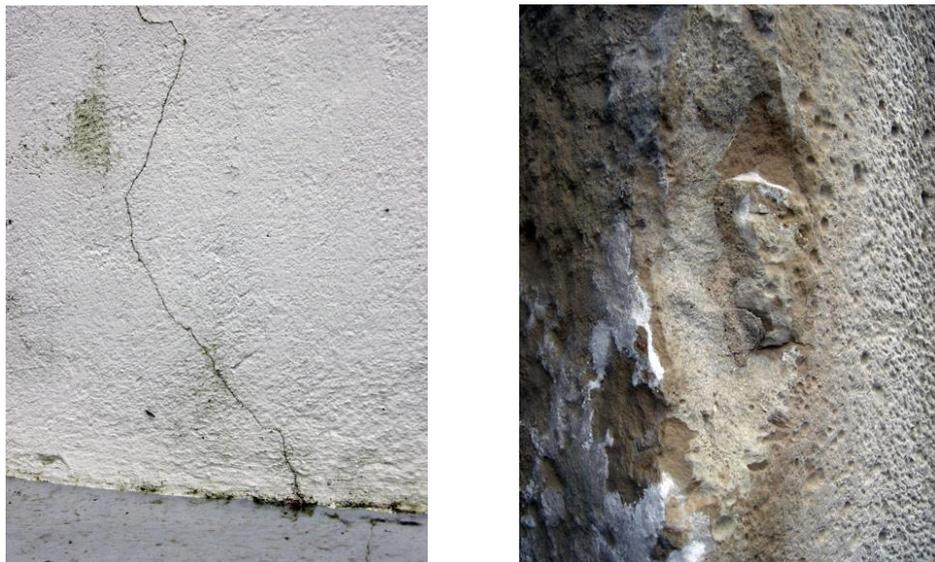
Figs. 11 e 12: Fissura existente no exterior da capela y pormenor da erosão existente no pórtico da capela. Capela de São Bartolomeu, Aveiro. Fotos: NR.
