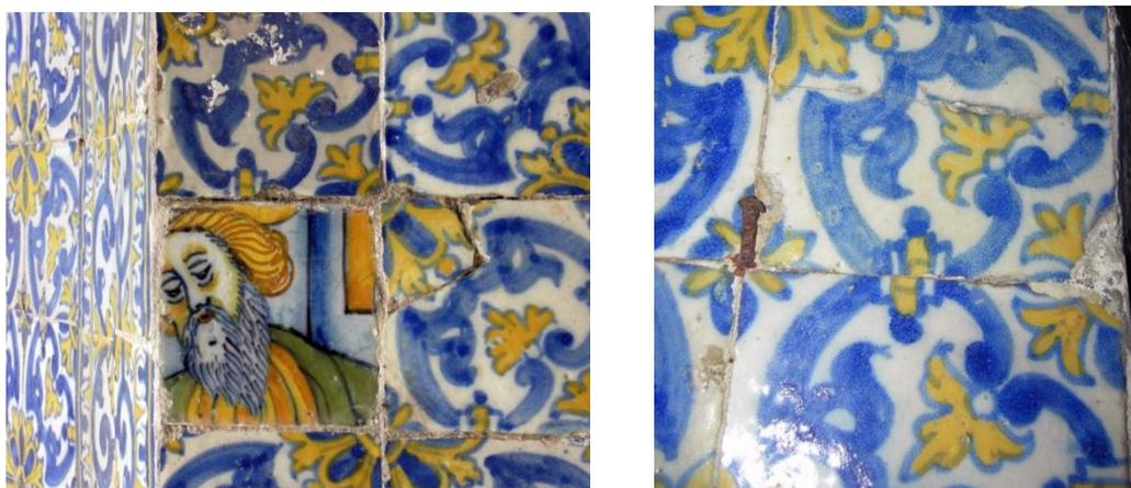
Figs. 20 e 21: O *azulejo figurativo* foi utilizado para preencher o espaço vazio criado pela perda de um outro azulejo aí aplicado originalmente e *Manchas de oxidação* provocadas pela inserção de um elemento metálico no painel de azulejos. Capela de São Bartolomeu, Aveiro. Fotos: NR.
