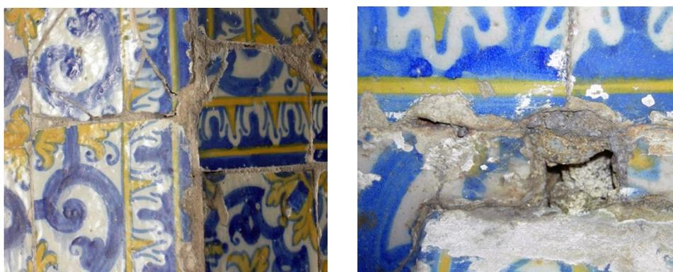
Fig. 18 e 19: Fissuras existentes em um painel de azulejos e lacunas existentes em um painel de azulejos. Capela de São Bartolomeu, Aveiro. Fotos: NR.
