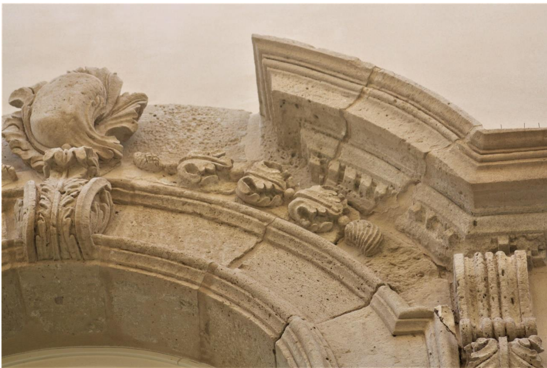
Figs. 21 y 22. Particolare mensole ed elementi decorativi floreali y Particolare delle decorazioni della parte superiore del balcone sinistro. 2019. Foto: MM.
